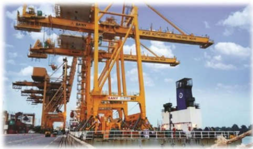
ติดตั้ง ณ ท่าเรือกรุงเทพ (ถ่ายจากภาพจริง)
